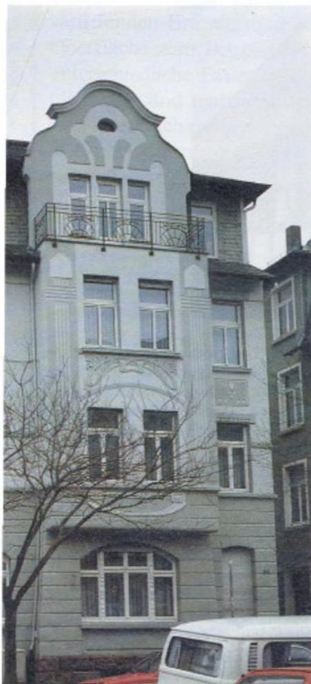
Wasserfreie Fassadenfarben dienen bei der Renovierung dieser schönen Jugendstilfassade als Schlußbeschichtung einer riß-sanierenden Leichtarmierung mit plasto-elastischen Werkstoffen; denn bei diesem Gebäude wurde eine tuchmatte Farboberfläche gewünscht.
