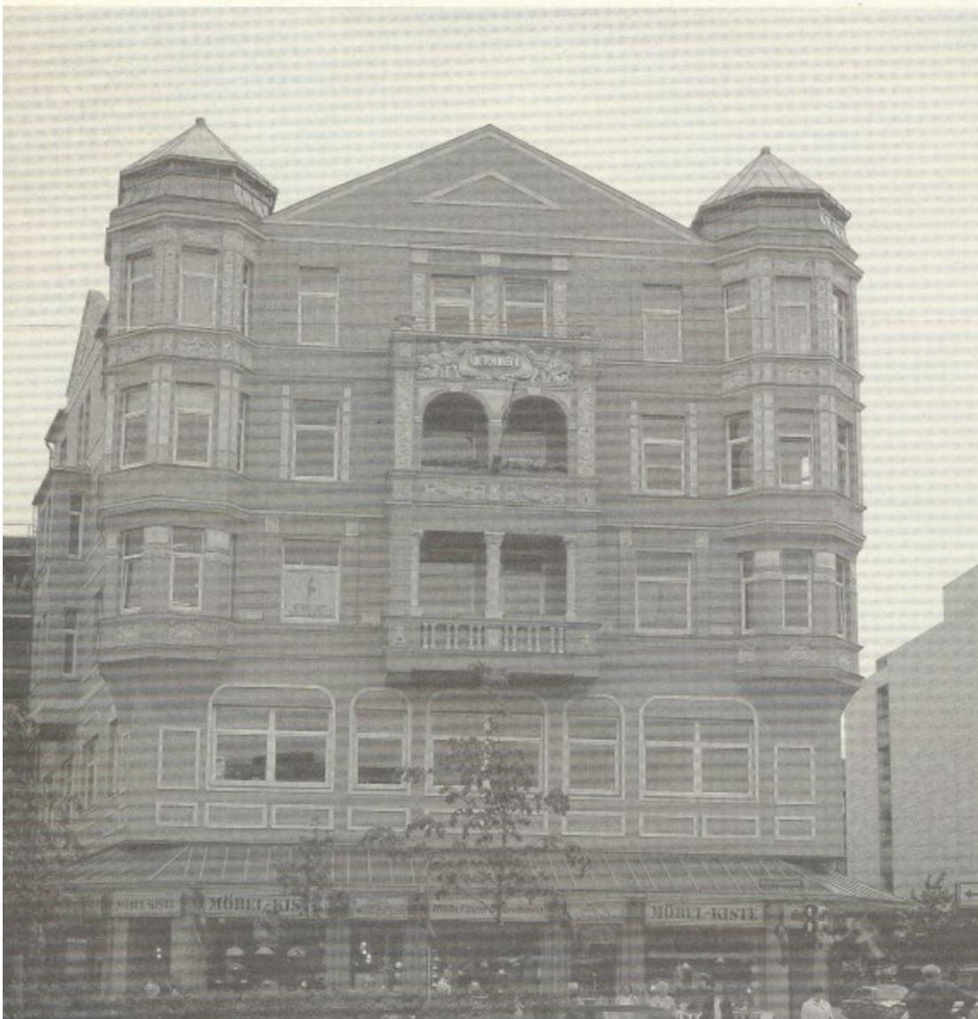
Fassaden, die von Schwundrissen überzogen waren, erscheinen nach einem zweimaligen Anstrichauftrag mit einer plasto-elastischen Fassadenfarbe optisch und technisch in einwandfreiem Zustand.
